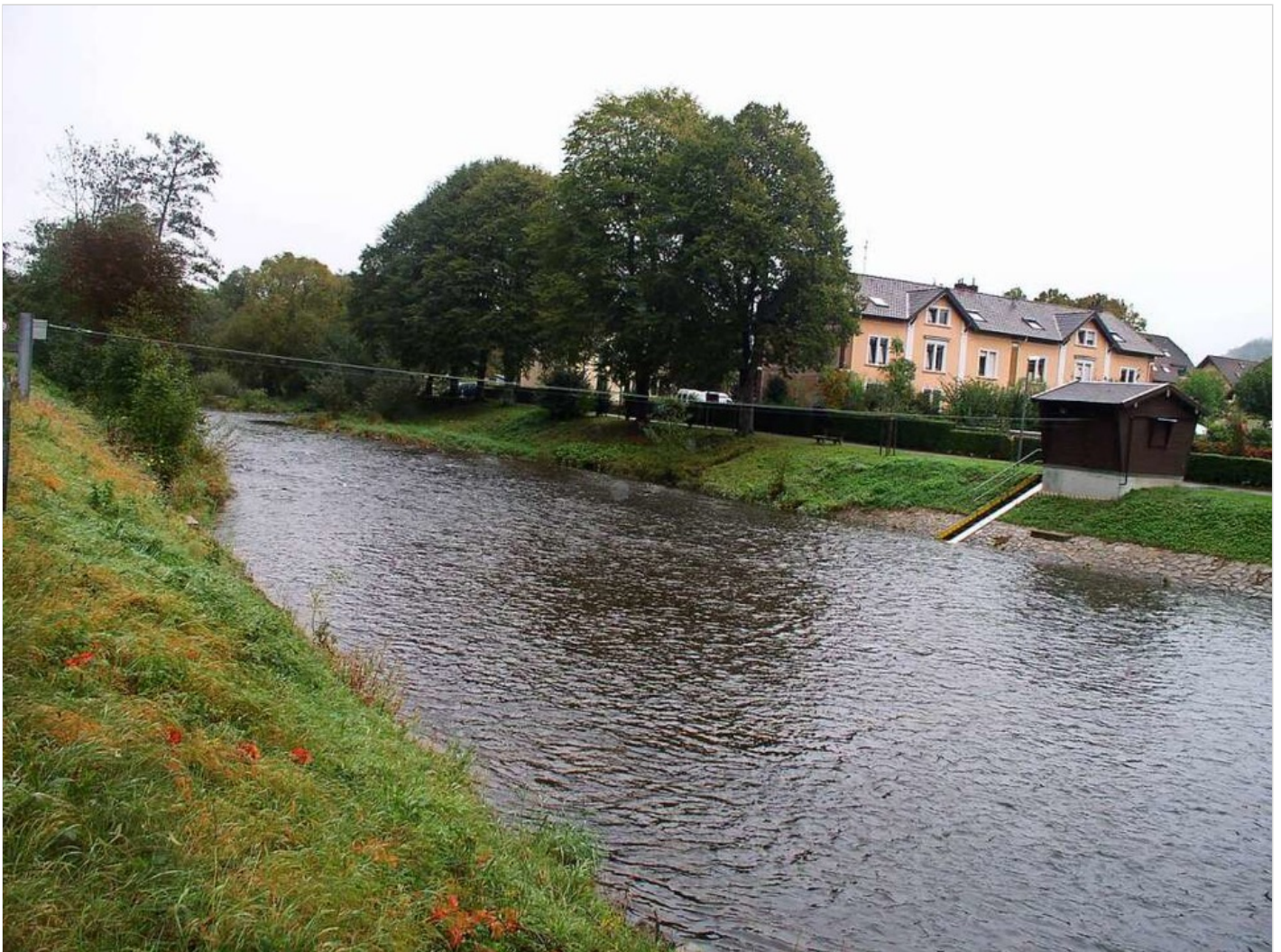
Am Pegelhäuschen in Gutach werden seit Jahrzehnten die Wasserstände der Elz gemessen. Foto: Regierungspräsidium Freiburg
