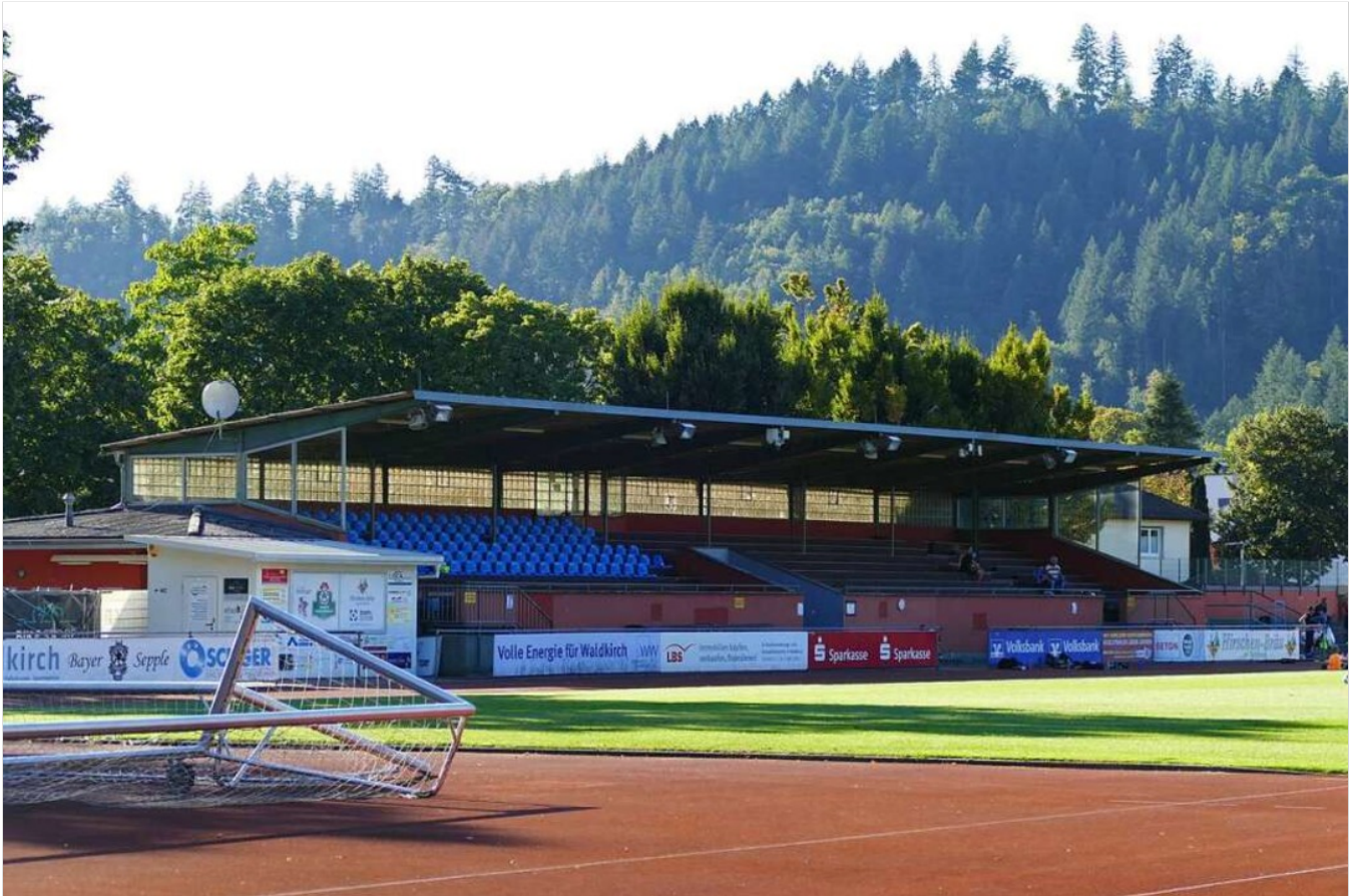
Teile der Tribüne des Elztalstadion sind sanierungsbedürftig. Foto: Sylvia Sredniawa
