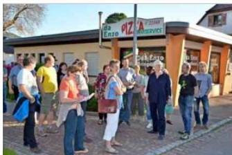
Vor-Ort-Termin in Kollnau zur Begutachtung und Bewertung der manigfaltigen Straßenschäden mit Experten, Räten und Anwohnern.
