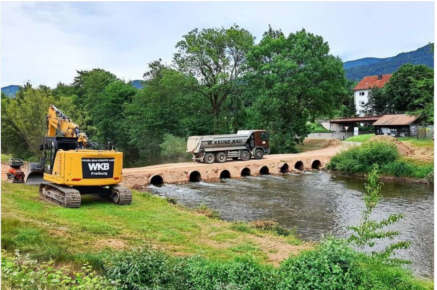
Bauarbeiten in Kollnau Foto: RPF
